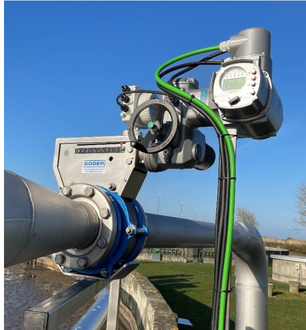
Iris ventil monteret på Nakskov RA
